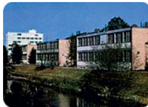
STF Winterthur Dipartimento Ventilazione e Climatizzazione Schlosstalstrasse 139 8408 Winterthur Tel. 052 260 28 02 Fax 052 260 28 03 info@stfw.ch
